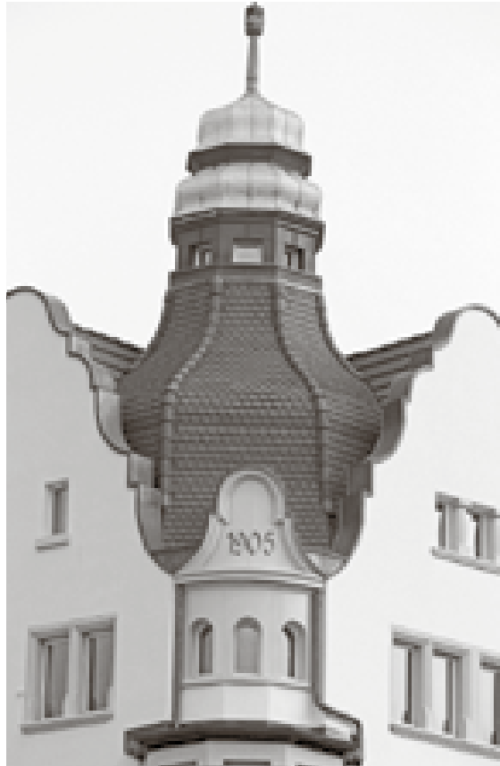
Solche kunstvollen Dachdeckerarbeiten gehören zum Handwerk der Würsch Söhne AG.
