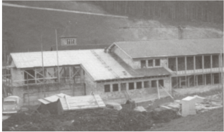
Auch der Neubau des Schulhaus 1 in Emmetten wurde von der Emmetter Dachdeckerfirma durchgeführt.
