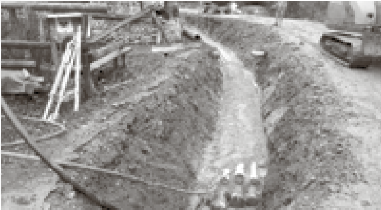
Quellableitungen im Bereich der Neublätzhütte
