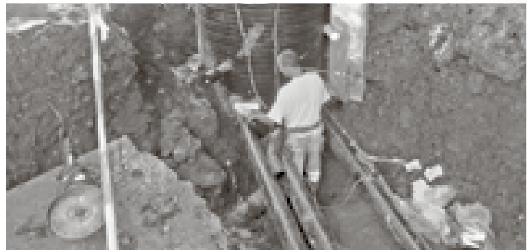
Sammelschacht bei der Grund-Brücke
