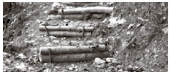
Tritteinbau – Rundweg Stock
