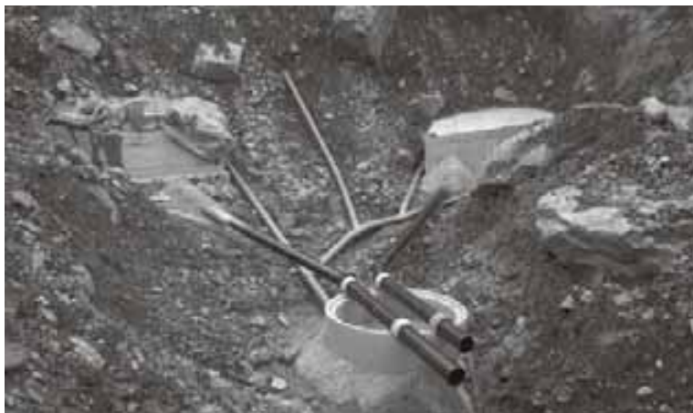
Quellfassungen A1/A2: Mit Abflussrohren, Sickerleitungen sowie dem Kontrollschacht im Vordergrund. Situation kurz vor der Eindeckung
