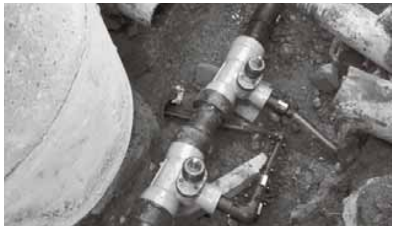
Neue Gussleitung. Das stillgelegte Eternitrohr konnte als Schutzrohr für zwei Hausanschlüsse verwendet werden.
