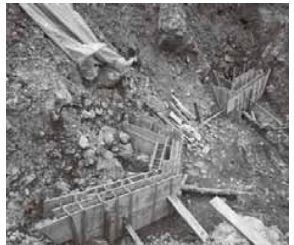
Quellfassungen A1/A2: Während den Bauarbeiten
