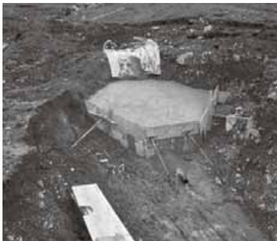
Quellfassung B: Decke frisch betoniert
