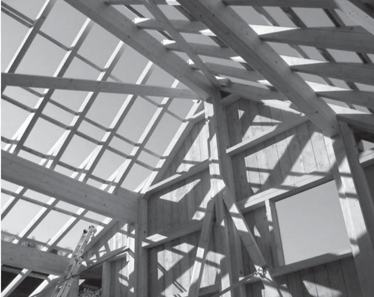
Dachstock vor Fertigstellung auf der Baustelle
