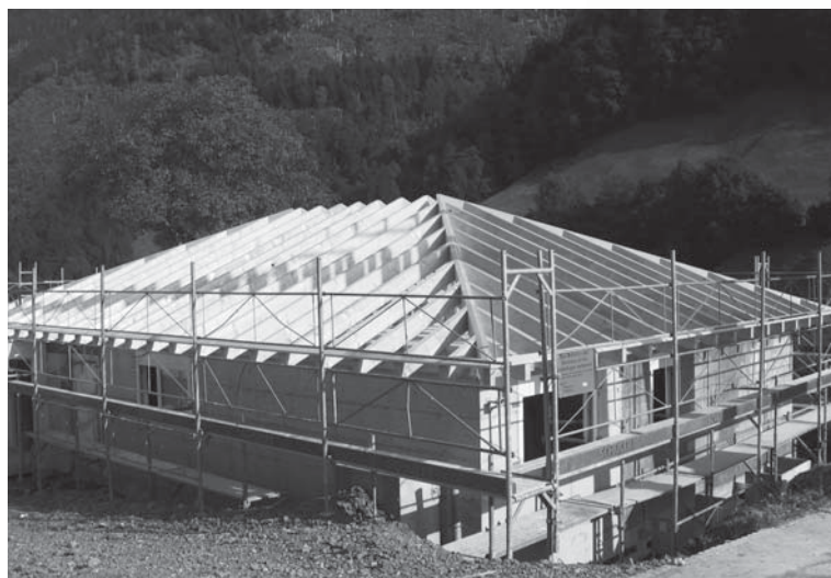
Aussenansicht einer Baustelle der Firma «Zimmerei Josef Würsch Emmetten»
