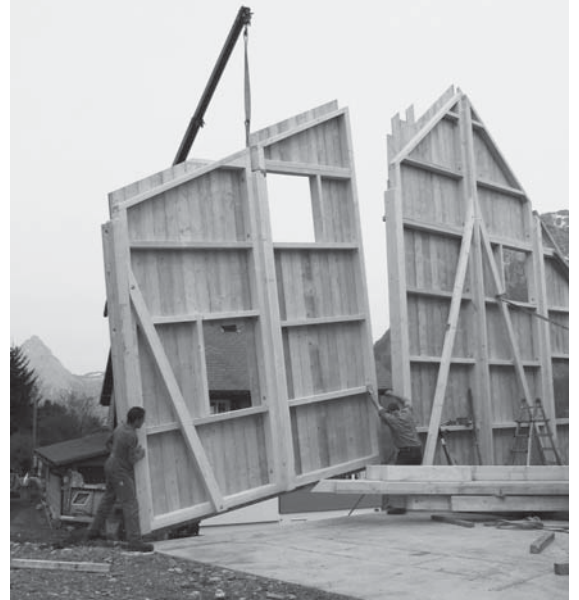
Ganze vorfabrizierte Hauswände werden durch die Firma «Zimmerei Josef Würsch Emmetten» direkt auf der Baustelle montiert.
