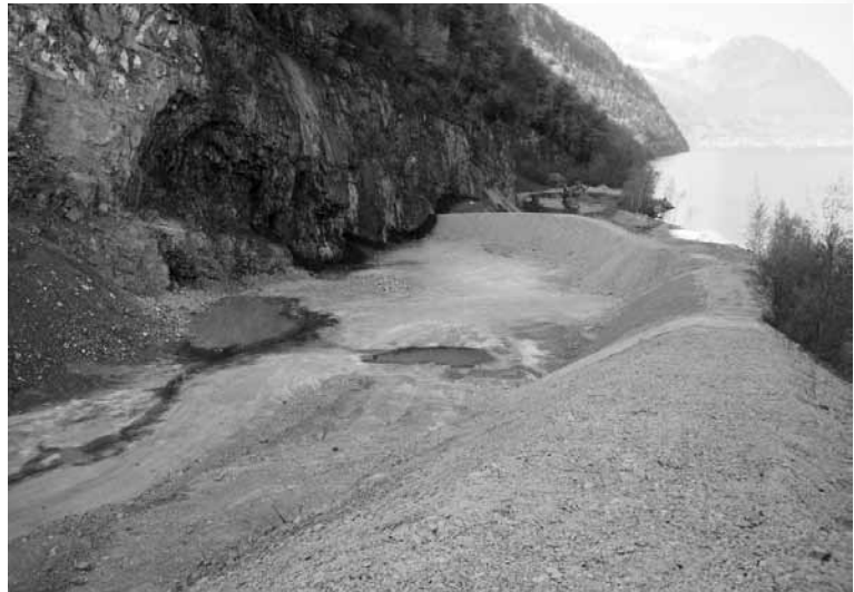
Abschlussdamm im Bau
