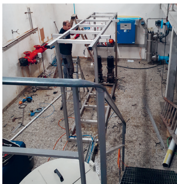
Rückbau Wasseraufbereitungsanlage Gorneren
