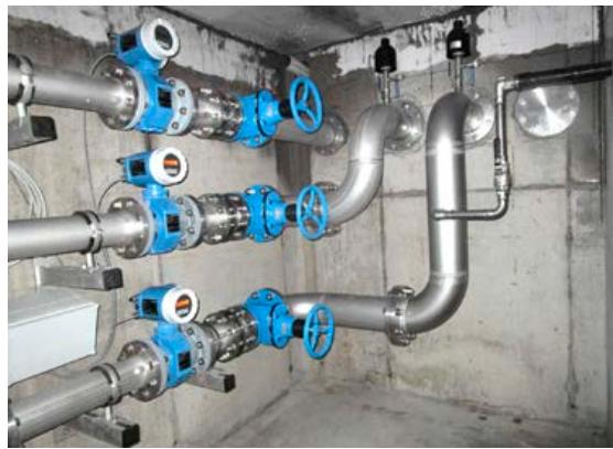
Links: Druckreduzie- rung und Ver- teilung auf die einzelnen Zonen
