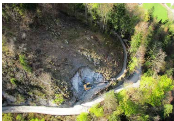
Links: Start der Aushub- arbeiten
