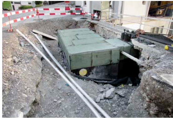
Links: Alter Verteil- schacht während des Rückbaus der Armaturen
