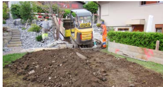
Strassenquerung Schynweg, ziemlich eng
