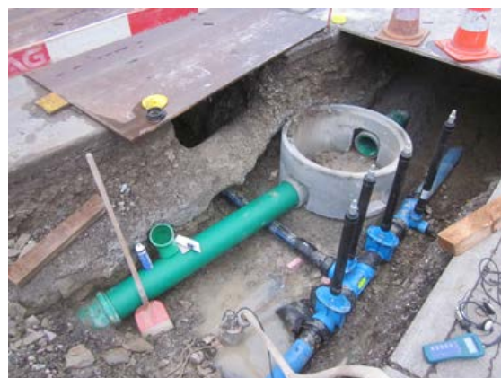
Leitungsbau im Bereich Waldi Verzweigung Ischenstrasse- Langmattweg
