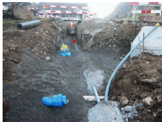
Leitungsbau nördlich des zu öffnenden Baches
