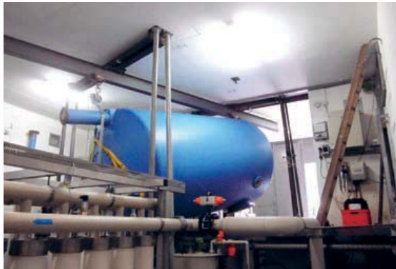
Ausbau der alten Sandfiltertanks
