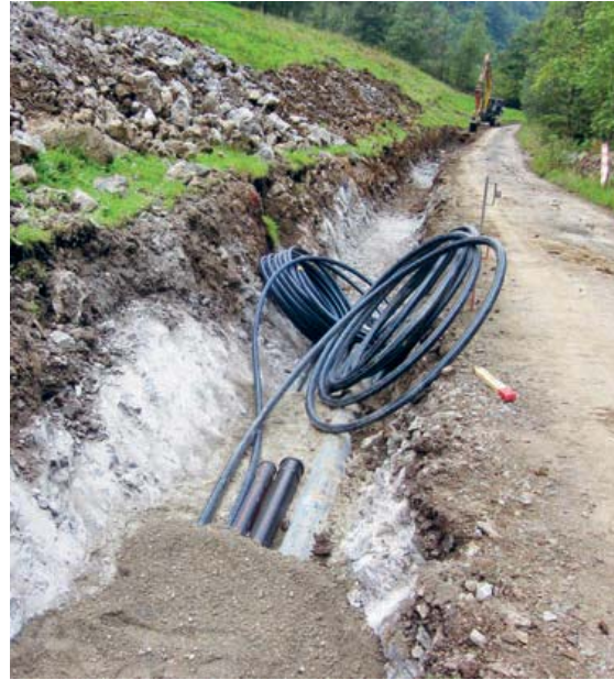
Links: Leitungs- bau im Bereich Hintergornern
