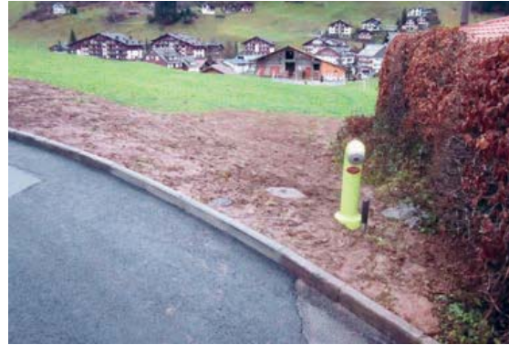
Links: Leitungsbau Seelisbergstrasse 8
