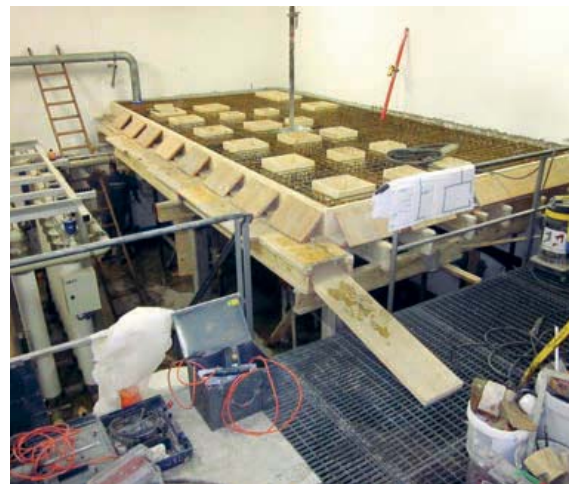
Zwischendecke kurz vor dem Betonieren
