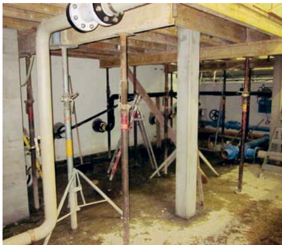
Blick unter die Schalung der Zwischendecke
