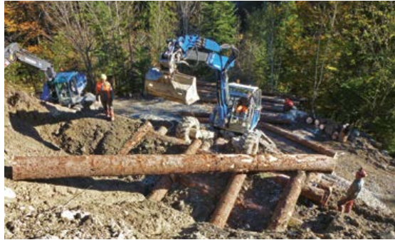
Auch der Holzkasten bei der Wandfluh wurde durch die Emmetter und Beckenrieder Forstfirma erstellt.
