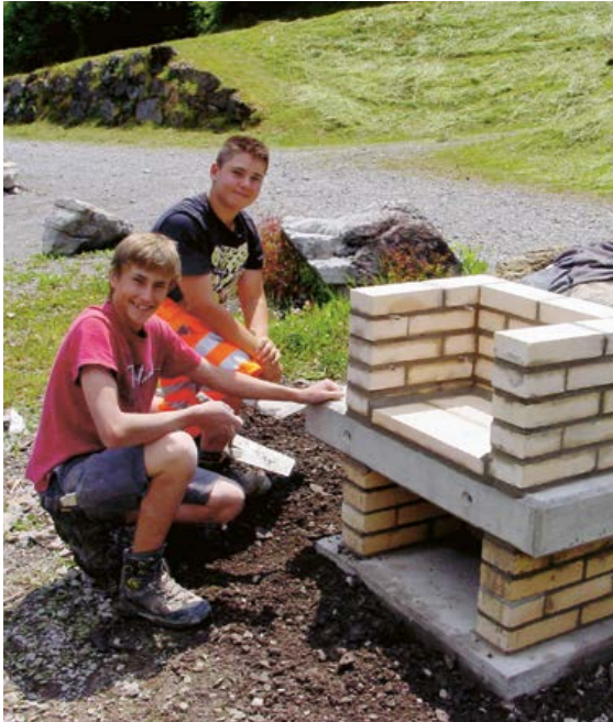
Dominik und Renato beim Mauern des Grills
